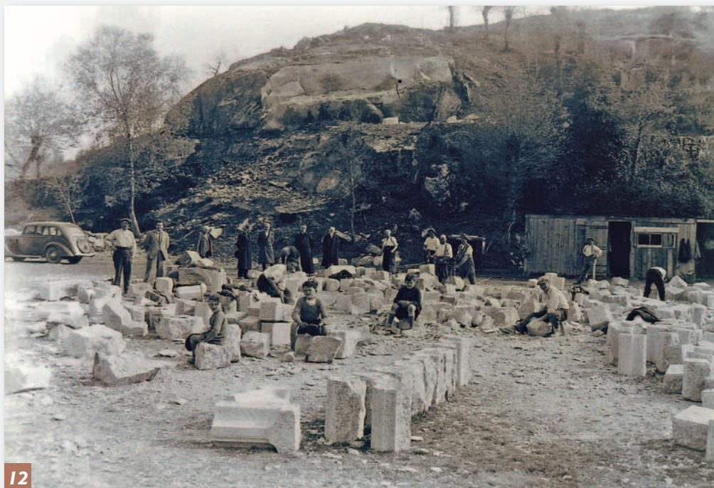
12 Chantier de taille du granit à Milvin. Au centre du groupe : Maurice Laurentin et le P. Logeais.
