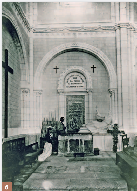
6 Les tombeaux en 1896-1897. Remarquer la croix de Montfort qui sera remplacée par le tableau de Claudius Lavergne, et la statue de Paul Belouin qui sera descendue dans la crypte.
