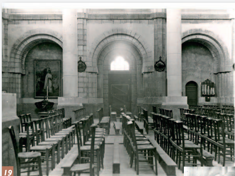
19 Intérieur de la nef. Les bases des colonnes, ainsi que les chapiteaux à la base des arcades sont à l'état brut. Remarquer le tableau de Delaunay « le Baptême de Christ » : il est encore entier. Photo probablement prise pendant l'hiver 1960-61. (Studio Vigneron)
