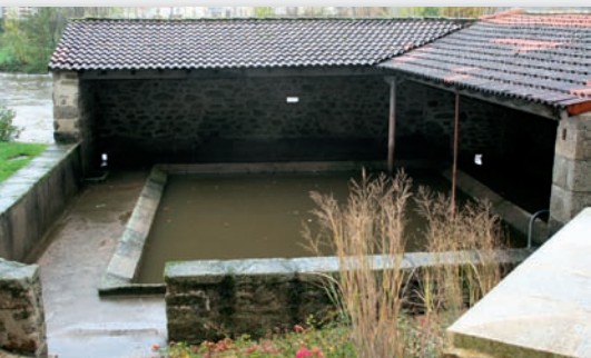
Le lavoir se trouve à peu près à l'emplacement de l'ancien Moulin de la Cour.
