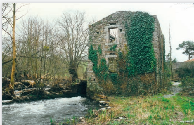
En 1988. Avant restauration.
