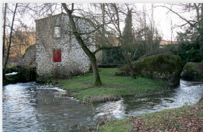
En 2009. Après restauration.
