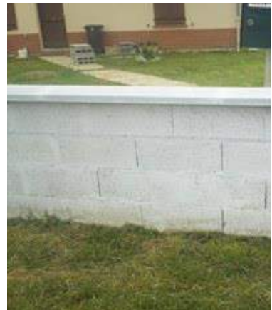
MUR DE CLOTURE NON ENDUIT
